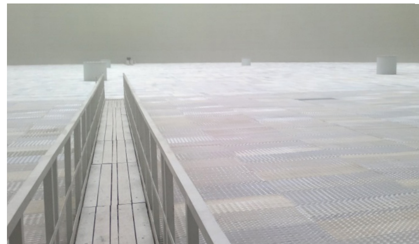
ВУП-60/120 установлен в самых больших башенных градирнях России. Площадь орошения 10000 м 2
