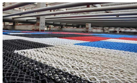
Пример установки ВСС-55 в башенной градирне.
