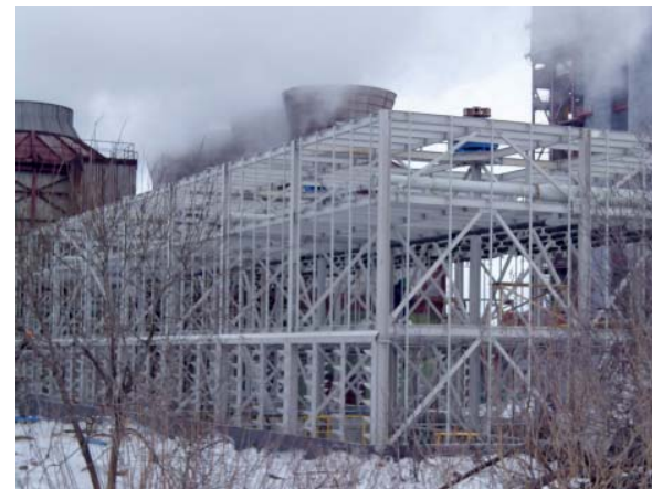
Монтаж градирни в зимнее время
