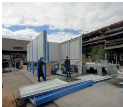
Монтаж трехсекционной градирни СВГ-16СП-НЕВА
