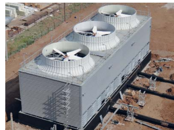
Сборная вентиляторная градирня СВГ-100-3, площадь орошения 300 м 2 .
