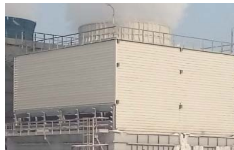
Сборная вентиляторная градирня СВГ-144-1 со стальными соединительными фланцами
