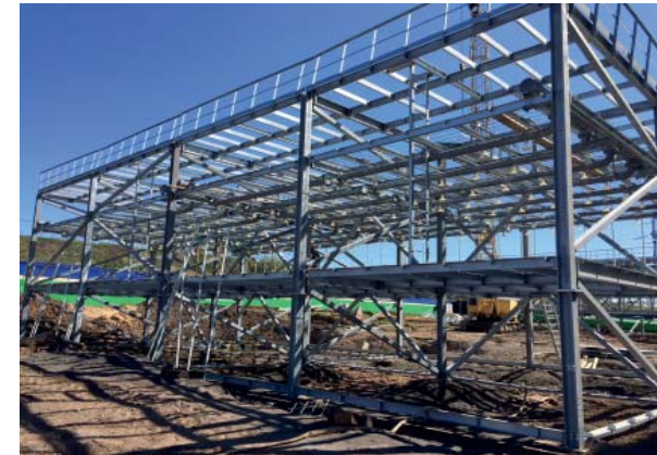
Предварительная сборка градирен СВГ-144М-2
