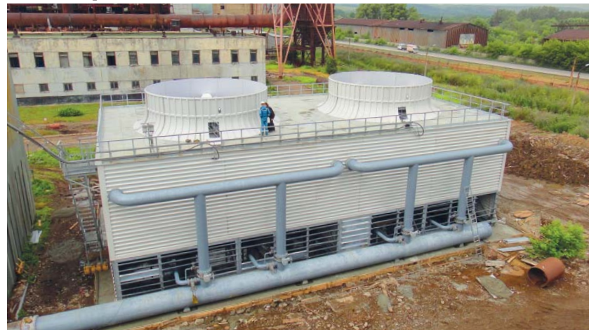
Сборная вентиляторная градирня СВГ-144-2, площадь орошения 288 м 2
