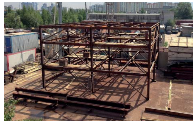
Контрольная сборка градирни перед горячим оцинкованием.
