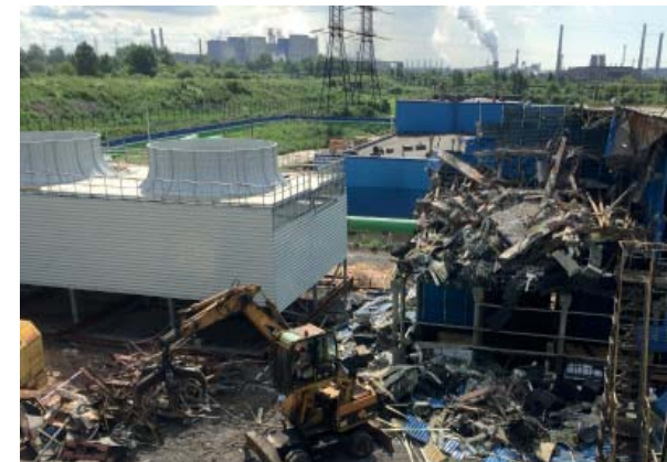
Демонтаж старой градирни ВГ-70
