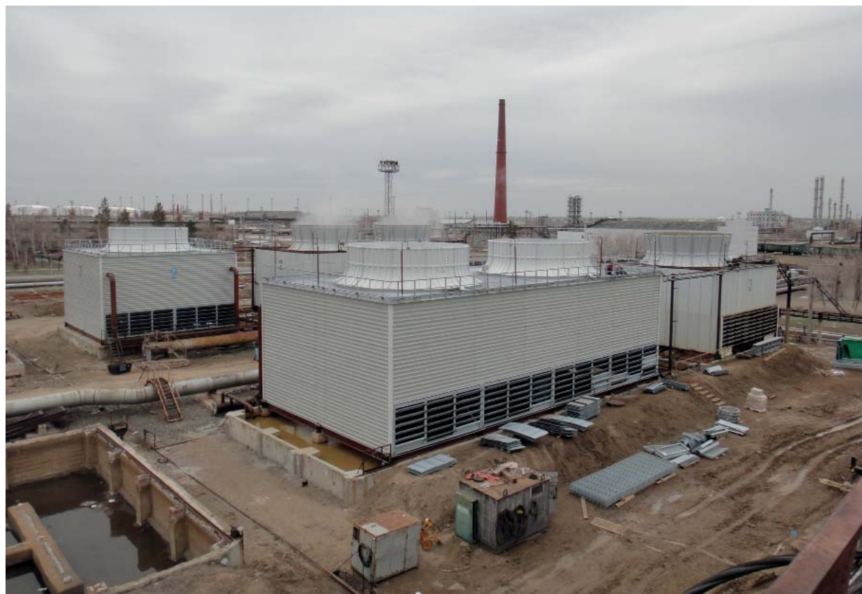
Вентиляторная градирня СВГ-144-2, площадь орошения 288 м 2 .
