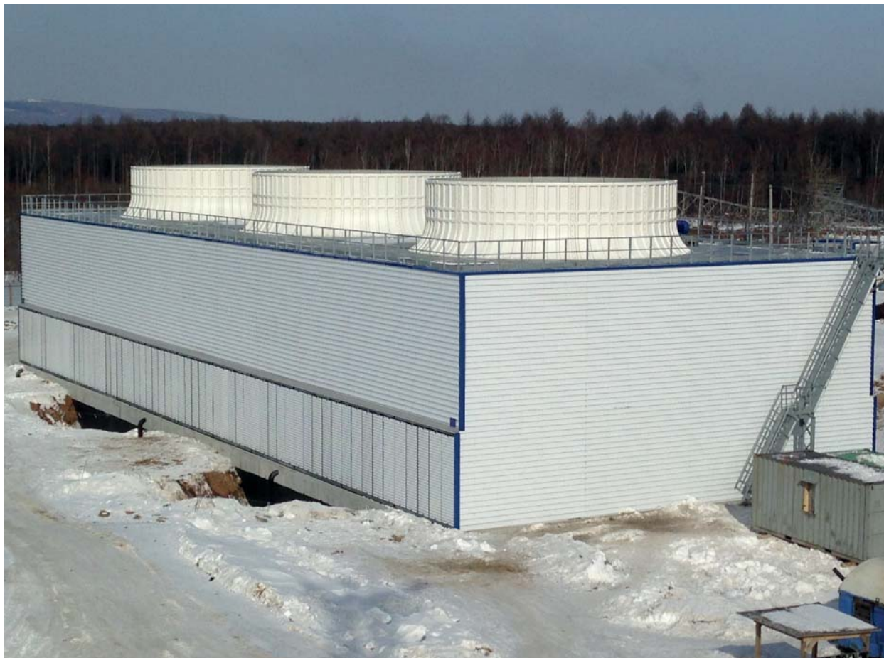
Поставка и монтаж градирни СВГ-324-3. Конструкция градирни рассчитана на работу в районах с сейсмичностью 8 баллов по шкале MSK-64.
