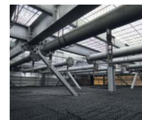
Водораспределительная система с форсунками из нержавеющей стали
