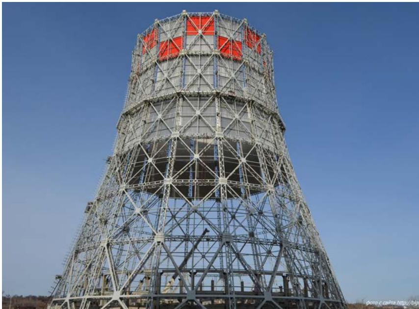
2015 г. Идет строительство градирни.
